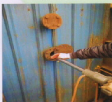
排气筒处理设备进口
